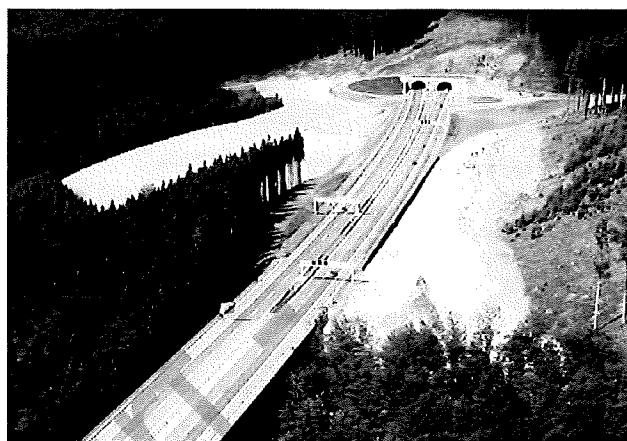
Verkehrsbeeinflussungsanlagen an der Thüringer Wald-Autobahn erhöhen die Verkehrssicherheit bei Starkwind.
