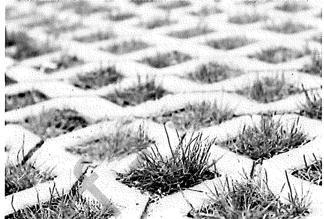
Rasenfugenpflaster sind eine Möglichkeit, versickerungsfähige Flächen zu erhalten und Abwassergebühren zu sparen.
