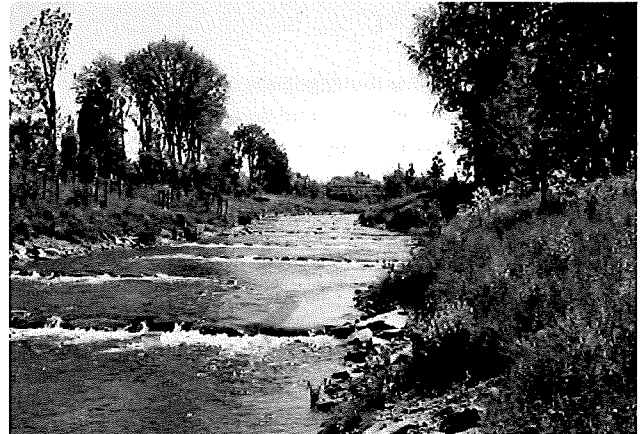
Nach dem Rückbau des Wehrs in Gispersleben wurde ein Rauherinne angelegt, das den Höhenunterschied überwindet und gleichzeitig die Durchgängigkeit sicherstellt.
