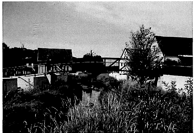
Hochwasserschutzmauern wie hier an der Werra in Harras schützen die flussangrenzenden Siedlungsgebiete vor Überschwemmungen.
